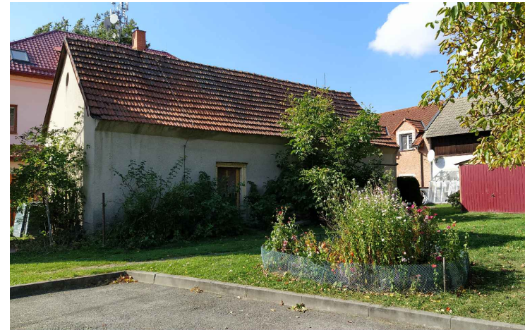
OBJEKT NA HŘIŠTI - STÁVAJÍCÍ STAV
