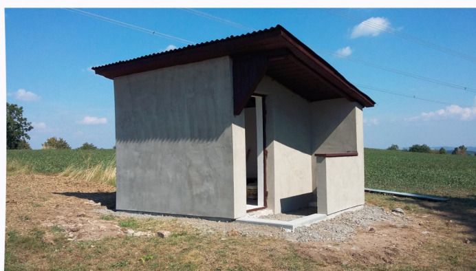
Oprava čekárny na rozcestí u Hlásnice
