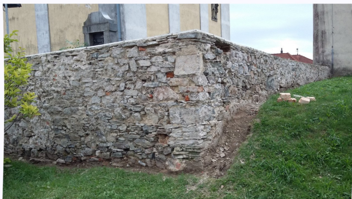
Rekonstrukce hřbitovní zdi
