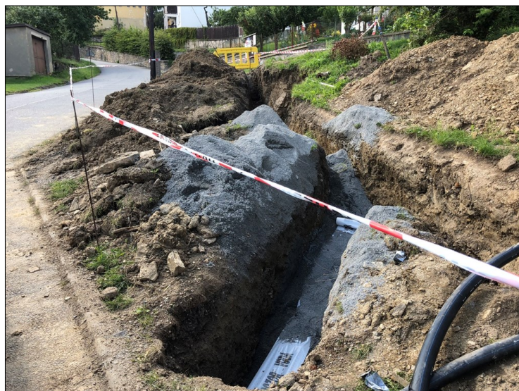
foto: Obnova vodovodního řádu v Hlásnici
